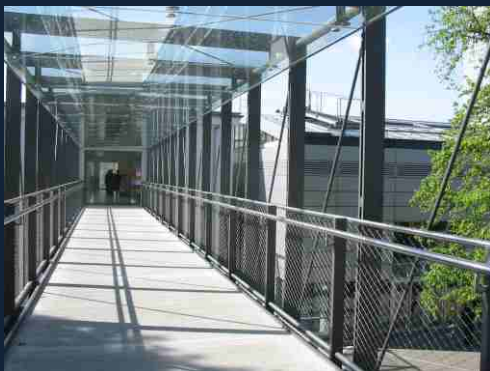
BVV BRNO (NEREZOVÉ SÍŤE X-TEND MW40/1,5) EXTERIÉR, ZÁBRADLÍ, ZABRÁNĚNÍ PÁDU OSOB
