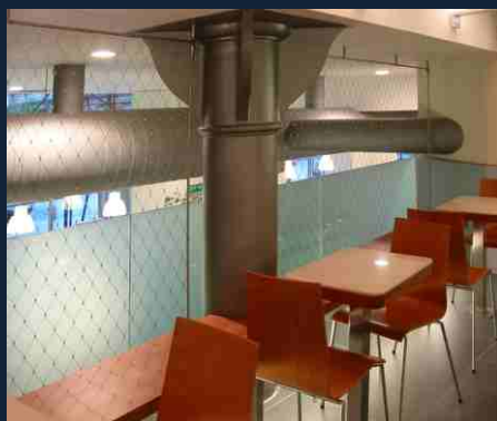
MCDONALD'S BRNO (NEREZOVÉ SÍŤE X-TEND® MW80/1,5) INTERIÉR, ZÁBRADLÍ, ZABRÁNĚNÍ PÁDU OSOB
