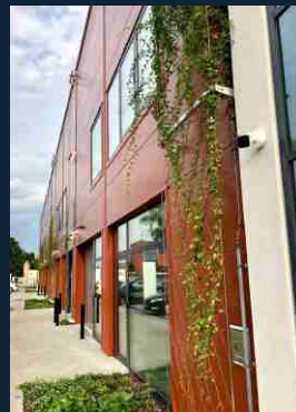
SVATOPETRSKÁ BRNO (X-TEND® MW200/2,0) EXTERIÉR, OZELENĚNÍ, TRELÁŽ
