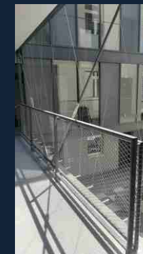
BD VOJTOVA (NEREZOVÉ SÍŤE X-TEND® MW40/1,5) EXTERIÉR, ZÁBRADLÍ, ZABRÁNĚNÍ PÁDU OSOB
